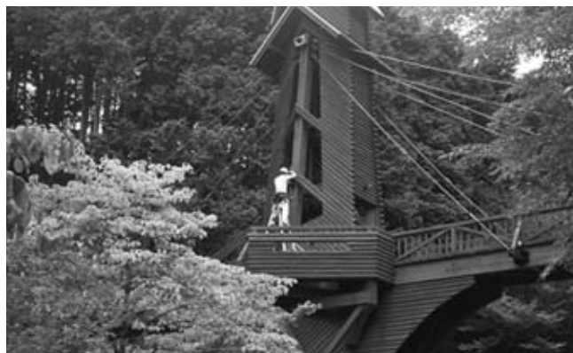
公園設備の点検
