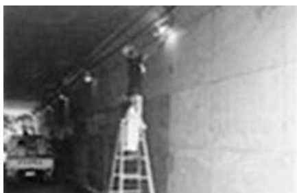
第二阪奈道路地下通路点検
