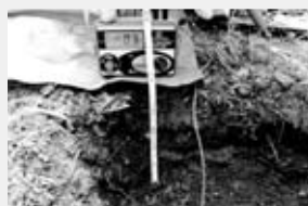
掘削後 1極打込み【参考：403Ω】
