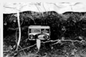
掘削後 3極打込み【参考：174Ω】
