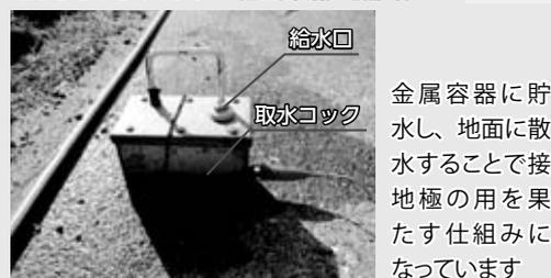
金属容器に貯水し、地面に散水することで接地極の用を果たす仕組みになっています
