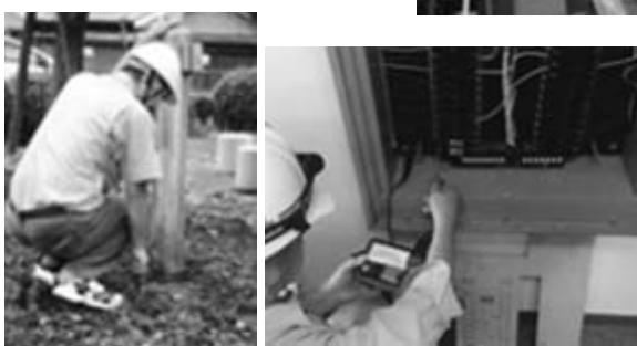
照明柱根元腐食確認
