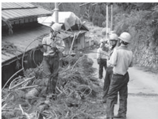
電線巻き取り
