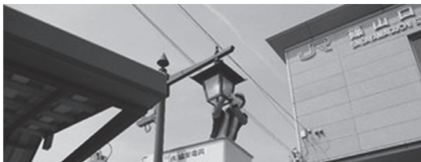
街路灯点検（JR篠山口駅前）
