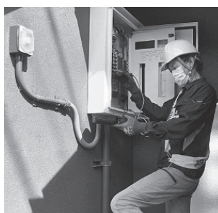
公衆トイレ電気無料安全点検(田辺支部)
