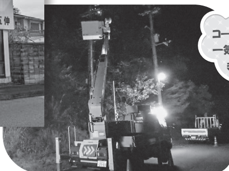
夜間高所作業の様子
