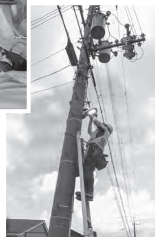
防犯灯の点検・清掃
